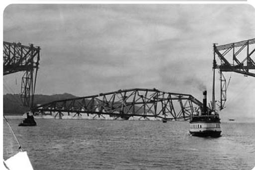
شکل ۱- پل کبک کانادا
